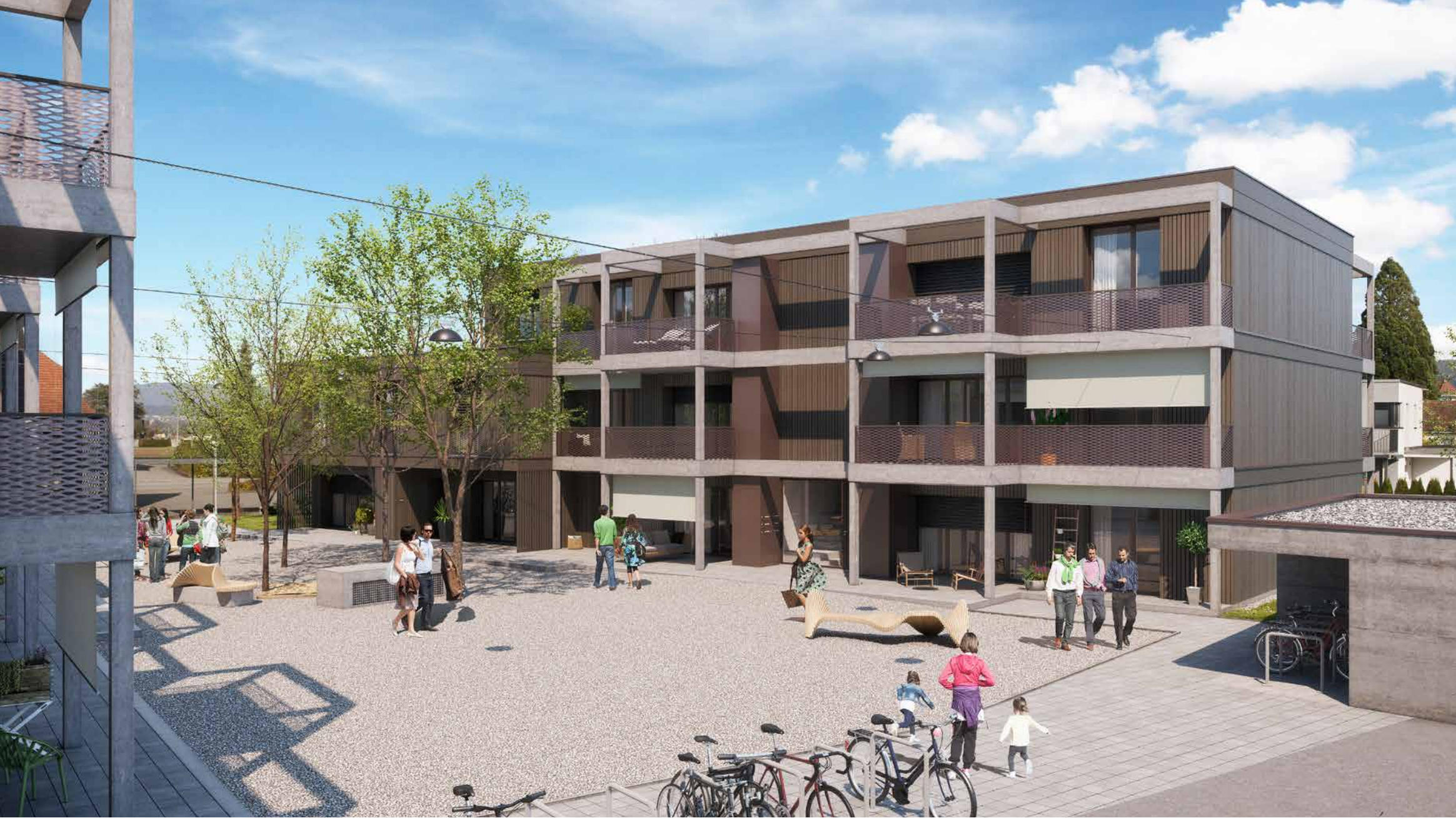
Die nachhaltige Holzfassade fügt sich harmonisch in die Umgebung ein.
